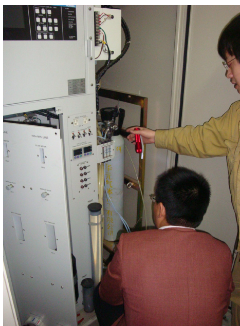
図4 中国某火力発電所脱硝設備出口のリークNH 3 監視モニタ
